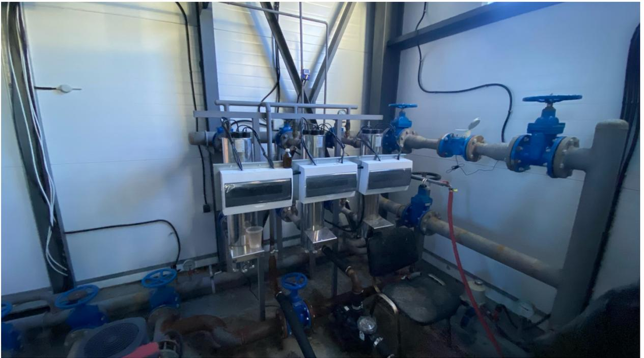
*Рис. 13. Участок УФ обработки воды*
